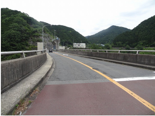
09.国道 25 号がダムの上を通る
